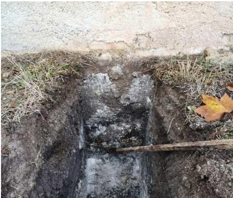
Photo 1 : Photo de la reconnaissance des fondations de l'existant (RF1).
