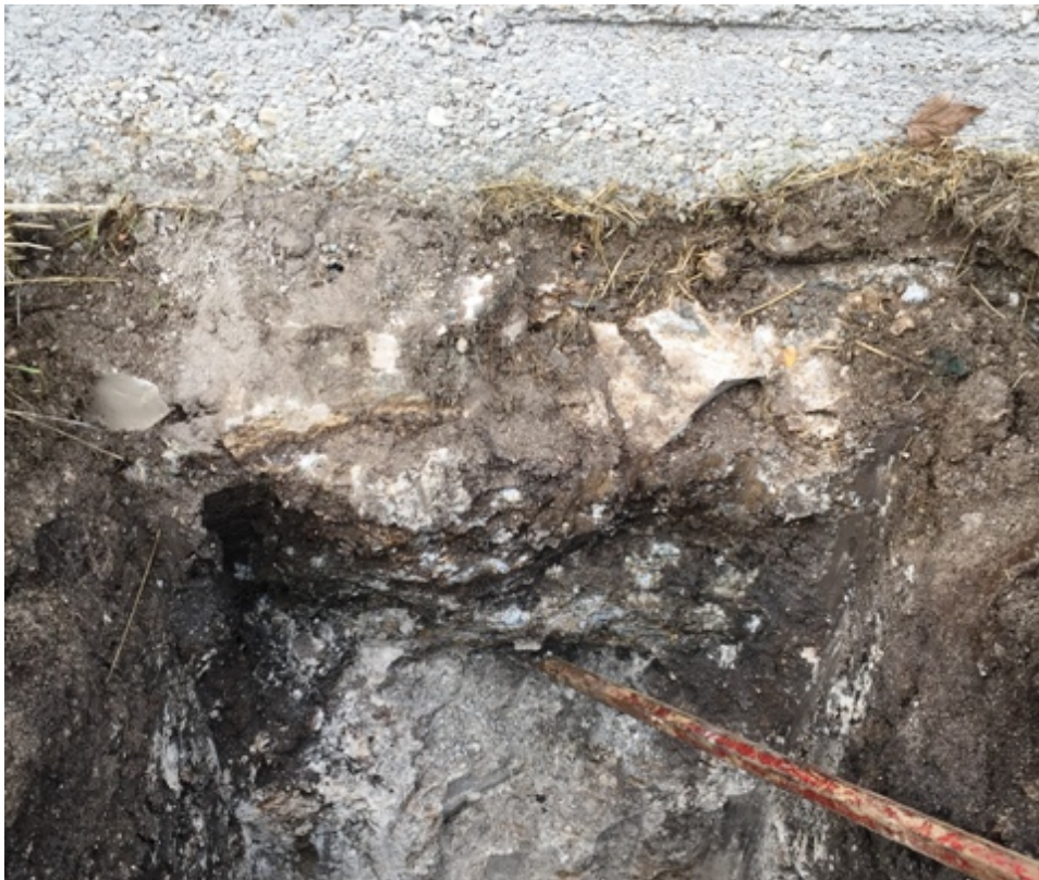
Photo 2 : Photo de la reconnaissance des fondations de l'existant (RF2).
